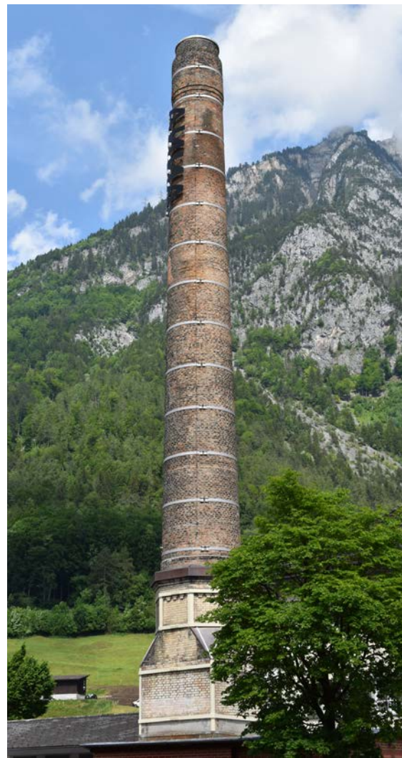
↑ Hochkamin in Ennenda aus dem 19. Jahrhundert. Nachdem er einzustürzen drohte, wurde er 2018 restauriert. 2020 wurde die Beschriftung «Anna» angebracht.
