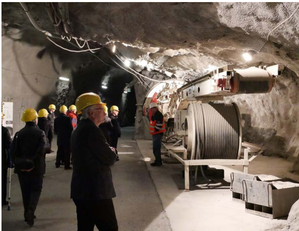
↑ Grosse Maschinen, grosse Kavernen: Im Versuchsstollen Hagerbach. (Fotos: Julian Reich)
