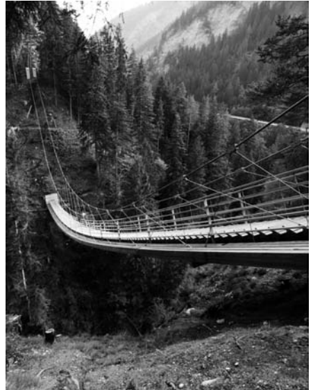
Elegant schwingt sich der neue Traversinasteg in der Viamala in die Höhe. (Foto Kulturraum Viamala)
